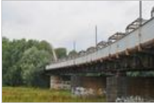
Magistrat ma projekt remontu kładki na moście żelaznym
